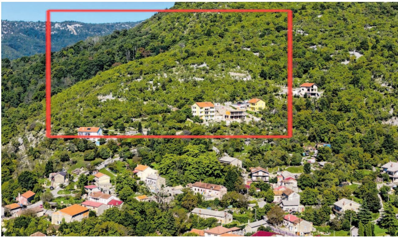
Crvenim kvadratom označena zona na kojoj će biti izgrađena vodosprema - Jelenski vrh
