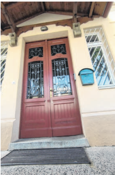
Restauracijom su vratima vraćeni profili, obrubi i ornamentika
