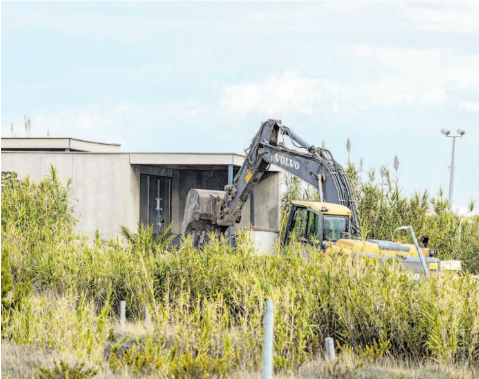
Teška mehanizacija uklanja bespravno sagrađeni objekt na paškoj plaži Katarelec
