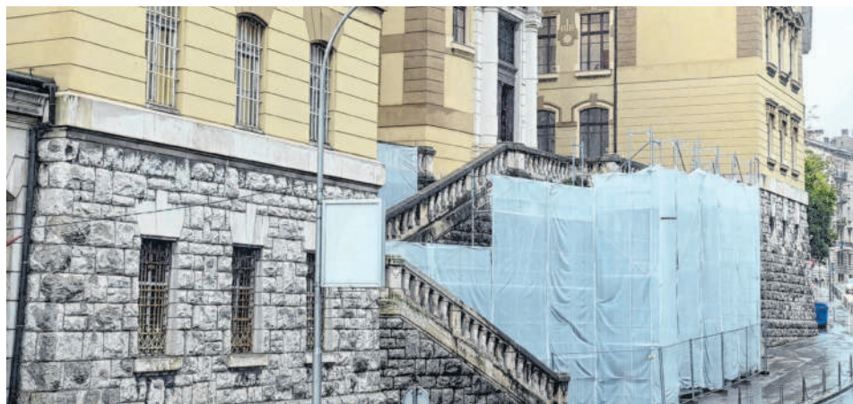
Nakon čišćenja kamen će se premazom dodatno zaštititi od atmosferskih prilika
