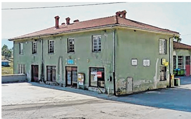
Postojeće stanje Vatrogasnog doma Mune
