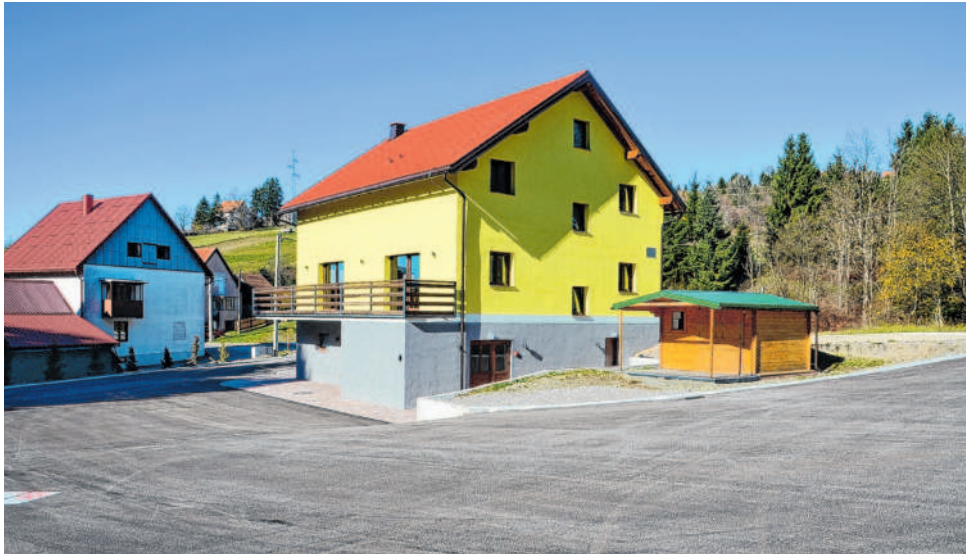
Nova kuća i novi asfaltirani parking prostor na sanjkalištu Bajt
