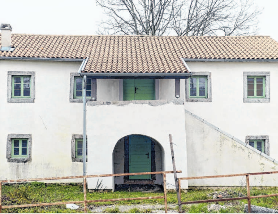
Objekt je obnovljen samo izvana, a unutra su goli zidovi - tzv. Linićeva kuća u centru Čavala
