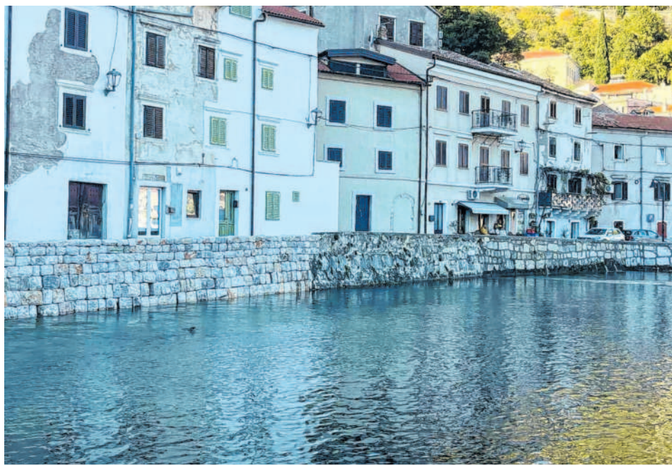
Bakarski SDP-ovci nezadovoljni izgradnjom potpornog zida na Jazu
