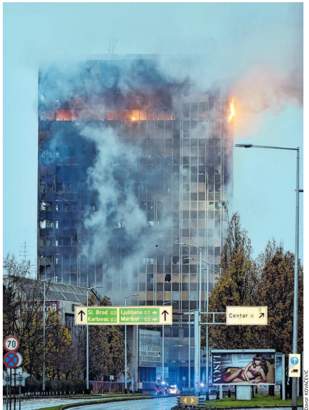
Požar je zahvatio gornje katove zgrade i brzo se proširio po čitavom neboderu
