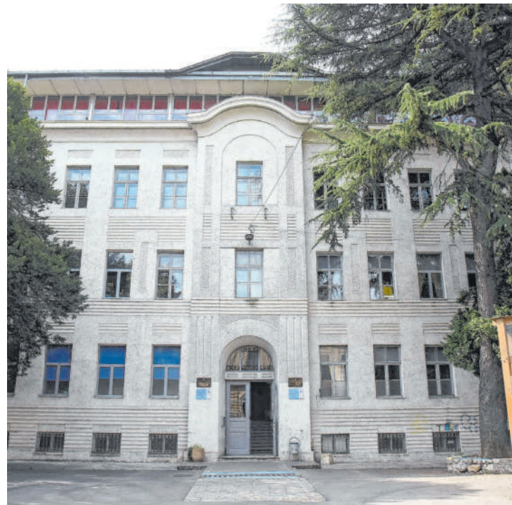
Građevinska tehnička škola u Ulici podhumskih žrtava
