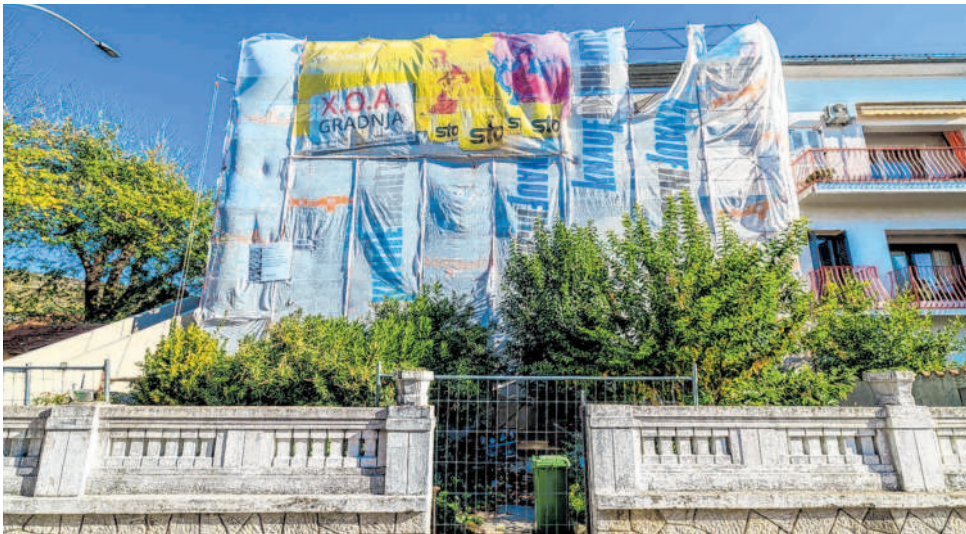
Na Domu prosvjete u Selcu u tijeku su fasaderski radovi
