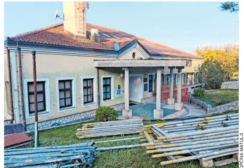
Obnova osnovne škole u Breščima je u tijeku
