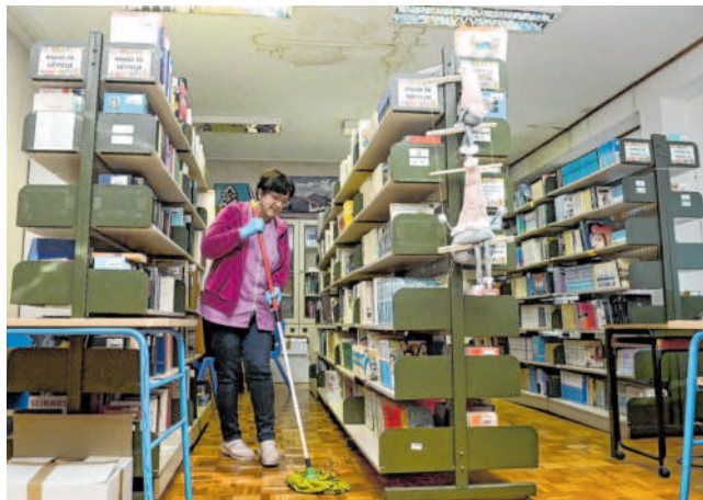
U školskoj knjižnici vlaga i na stropu i na podu
