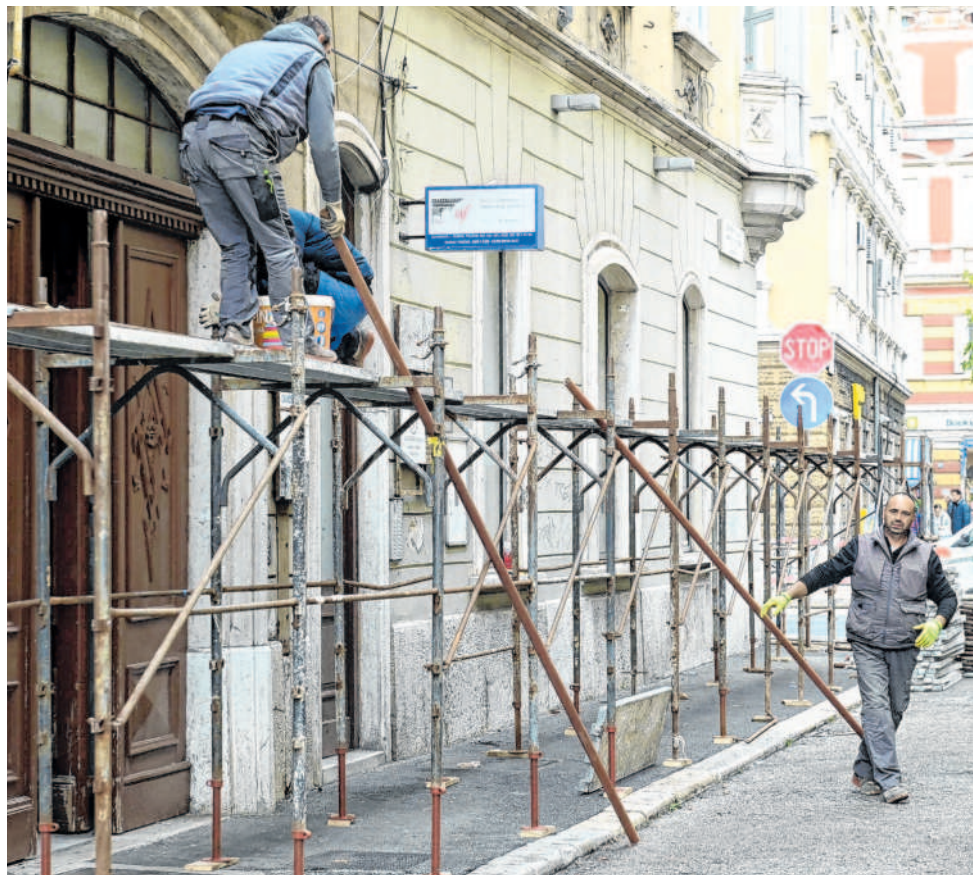
Zaštitna skela postavljena je u Zanonovoj i Adamićevoj ulici zbog zaštite prolaznika
