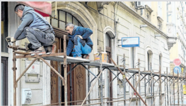
Postavljanje skele uvjet za sanaciju zgrade
