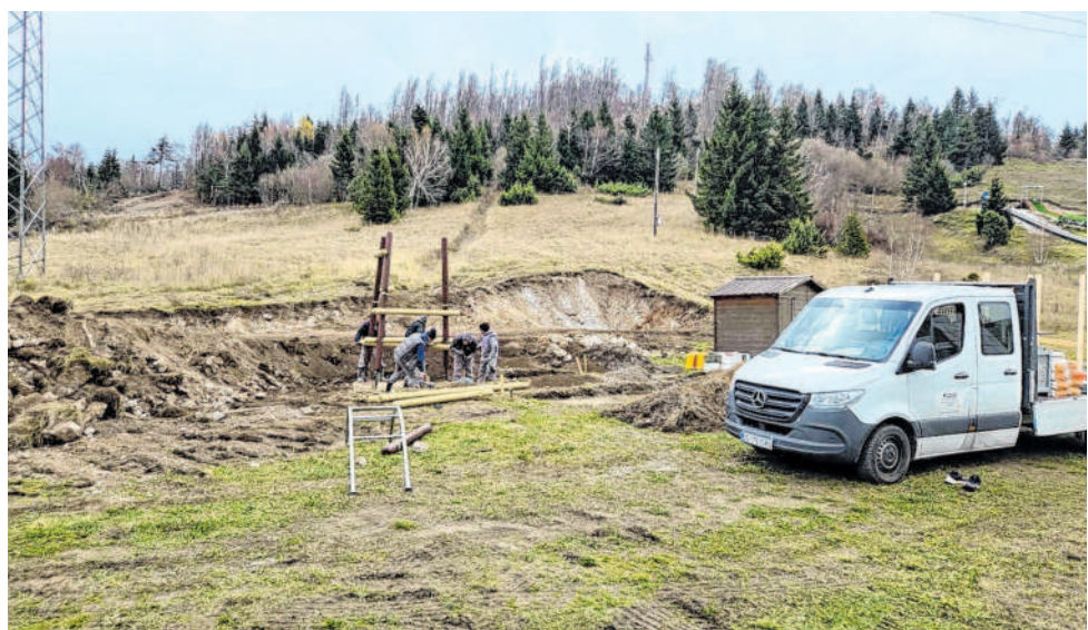
Radovi na postavljanju novih dječjih sprava na Plasi, nedaleko od Vrata
