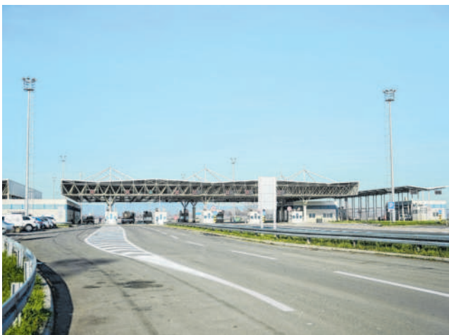
Novoizgrađeni granični prijelaz Gradiška
