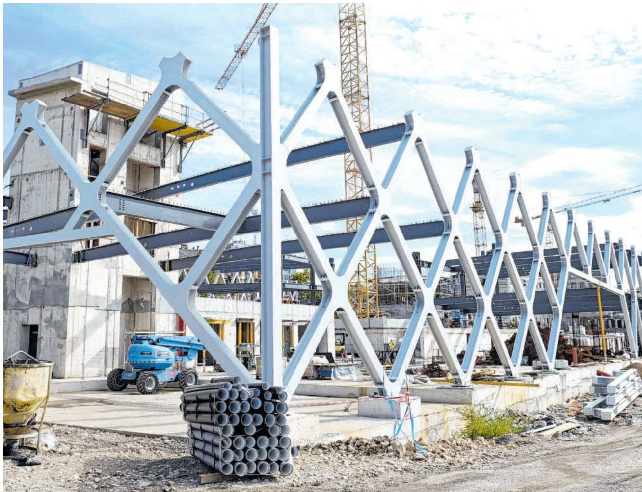
Investitor još ima četiri mjeseca za završetak projekta - gradilište novog autobusnog kolodvora na Žabici
