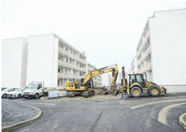
Gradilište stambenih zgrada u Petrinji
