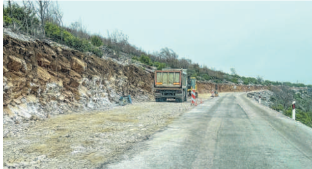
Radovi kraj Predošćice
