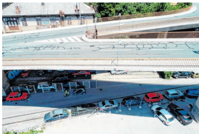
Sanacija će obuhvatiti i odvojak prema Pećinama
