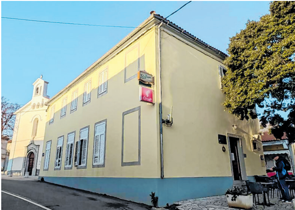
Zgrada društvenog doma u Korniću
