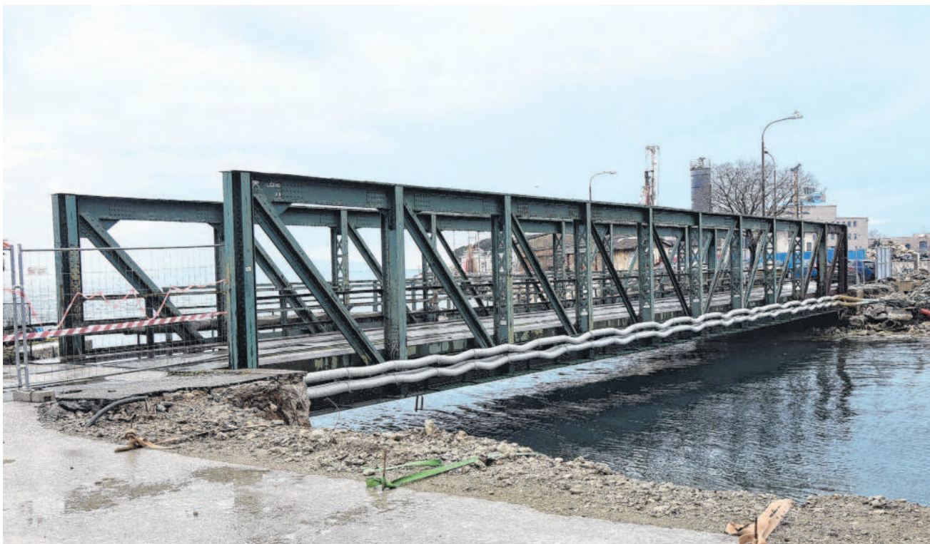
HŽ Infrastruktura planira srušiti željeznički most preko Rječine
