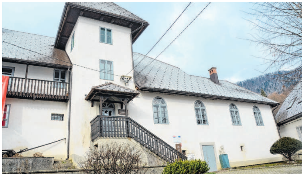
Energetska obnova čabarskog dvorca trebala bi biti gotova u veljači
