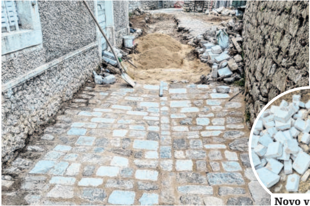
Novi kamen već se počeo ugrađivati u ulice
