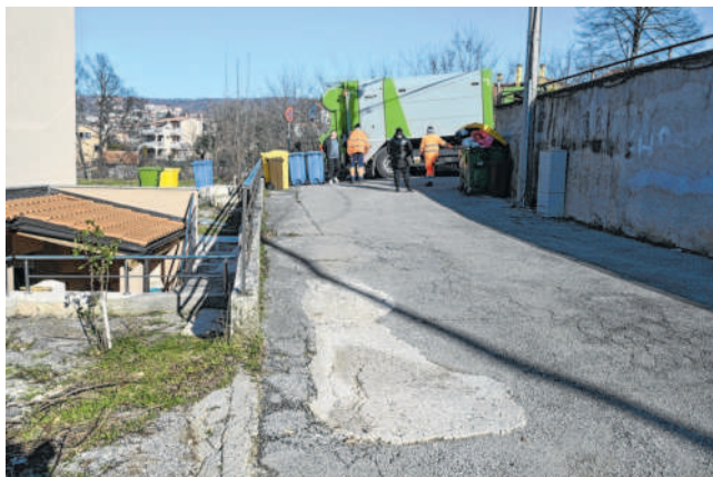
Vozila Čistoće kupe otpad na početku prilazne ceste višestambenoj zgradi
