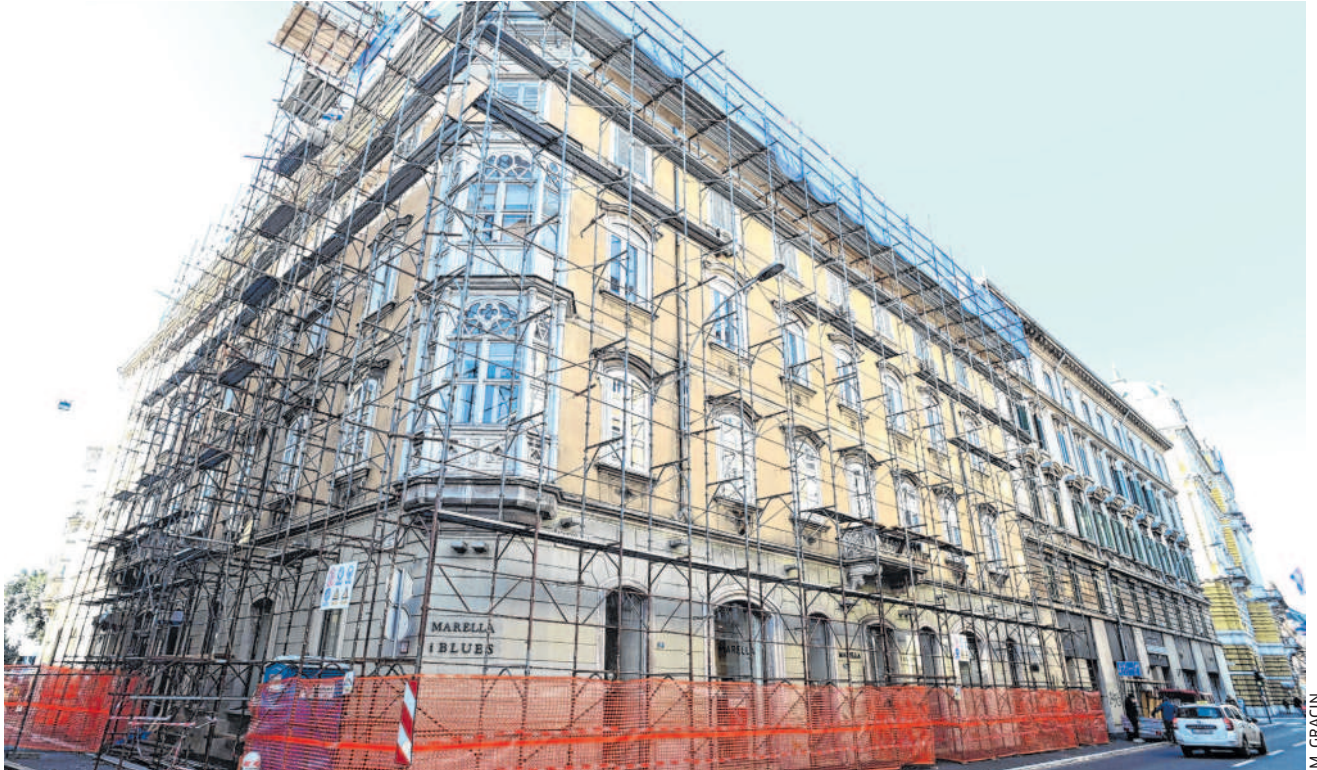
Osim postavljanja zaštitne skele, malo je toga učinjeno na sanaciji Zanonove 1
