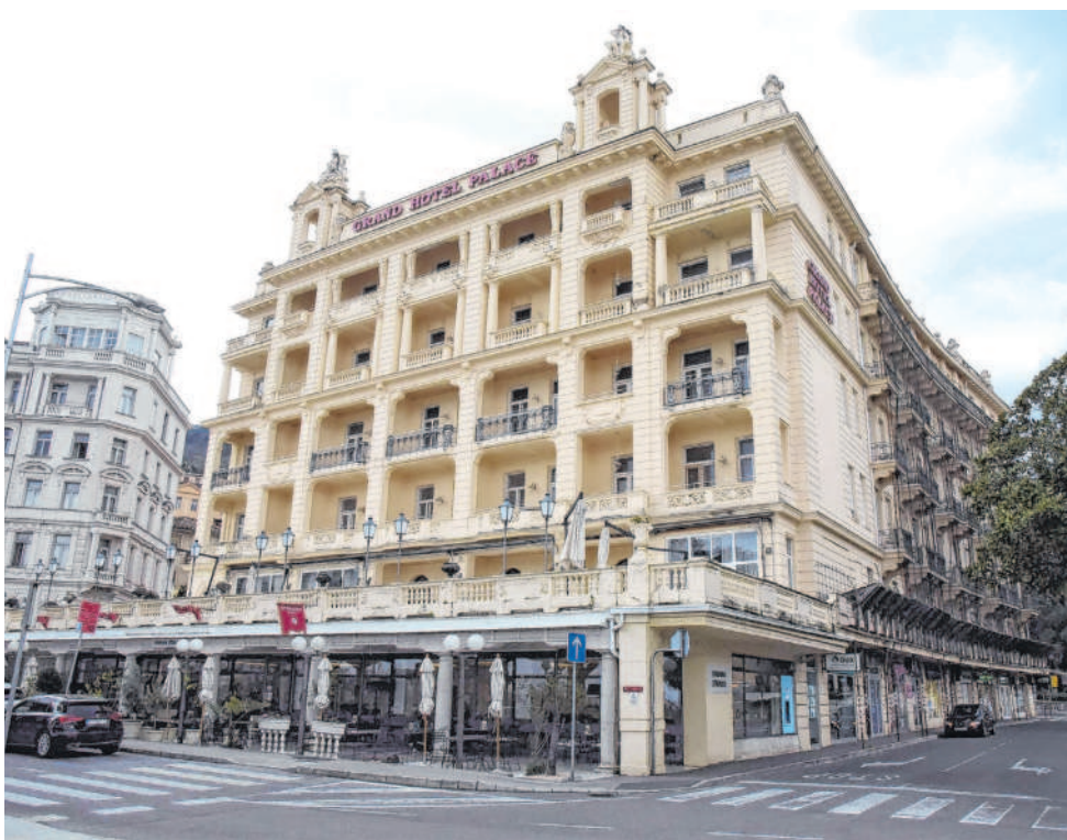
Hotel Palace čeka rekonstrukciju
